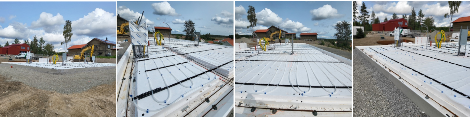
Budowa płyty fundamentowej energoszczędnej
